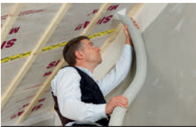
Instalación de barreras de vapor con aislamiento térmico por insuflado
