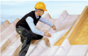
Instalación de barreras de vapor durante el saneamiento de tejados desde el exterior
